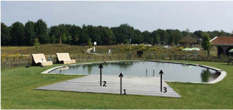
Figuur 2 Overzicht en monsterpunten zwembijver II 1: zwembijver, 2: voor helofytenfilter, 3: na helofytenfilter
