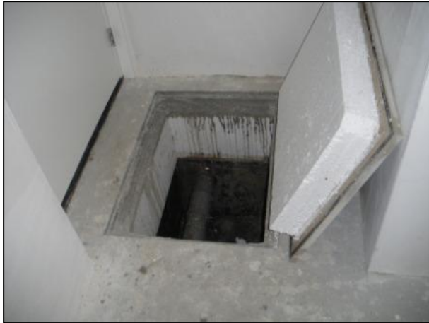
Afb. 7 Isolatie in de vloer
