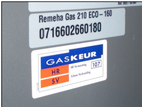
Afb. 9 CV-ketel met HR keur (HR107)
