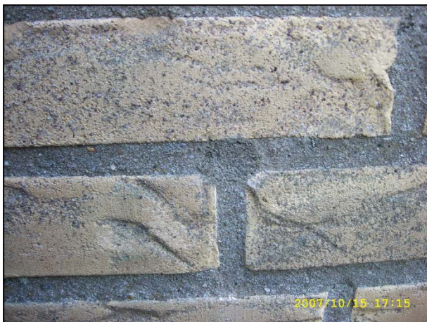
Afb. 3 Boorgat in de gevel
