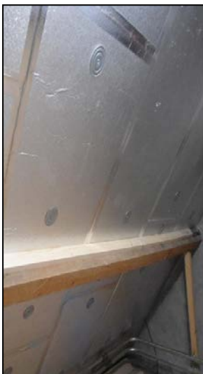
Afb. 6 Isolatie op vliering tussen de gordingen
