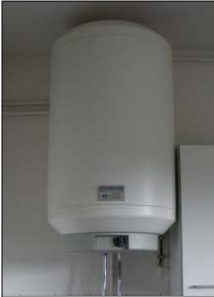
Afb. 12 Elektrische boiler (links) en geiser (rechts)
