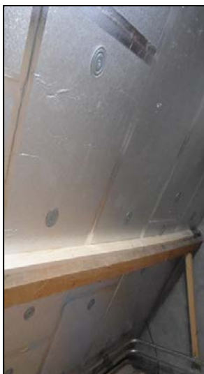
Afb. 6 Isolatie op vliering tussen de gordingen
