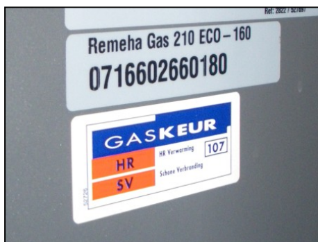
Afb. 9 CV-ketel met HR keur (HR107)
