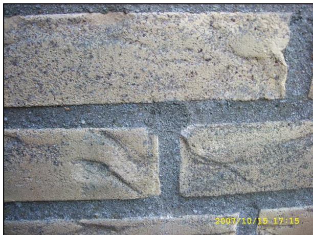
Afb. 3 Boorgat in de gevel
