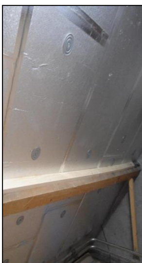
Afb. 6 Isolatie op vliering tussen de gordingen
