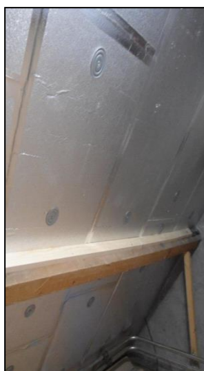
Afb. 6 Isolatie op vliering tussen de gordingen
