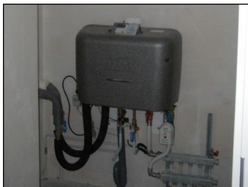
Afb. 11 a. Stadsverwarmingsunit (tevens tapwater) b. Secundaire stadsverwarmingsaansluiting (alleen CV)
