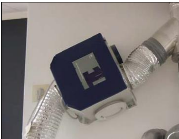
Afb. 13 Ventilatieunit voor enkel mechanische afzuiging
