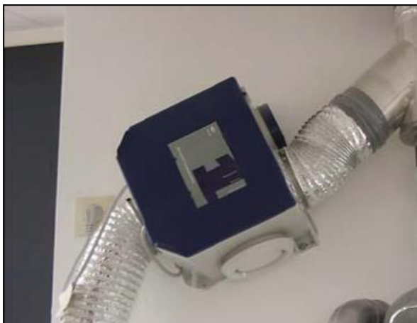
Afb. 13 Ventilatieunit voor enkel mechanische afzuiging
