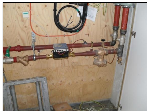
Afb. 11 a. Stadsverwarmingsunit (tevens tapwater) b. Secundaire stadsverwarmingsaansluiting (alleen CV)
