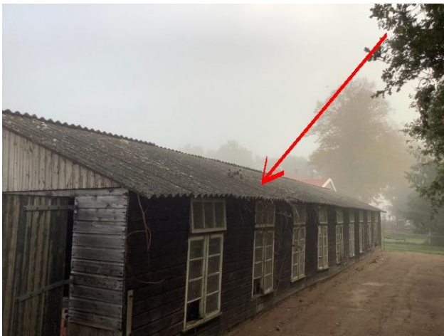
Golfplaten op dak van schuur uit 1955 10-15 % chrysotiel en 2-5 % crocidoliet Risicoklasse 2 buitensanering
