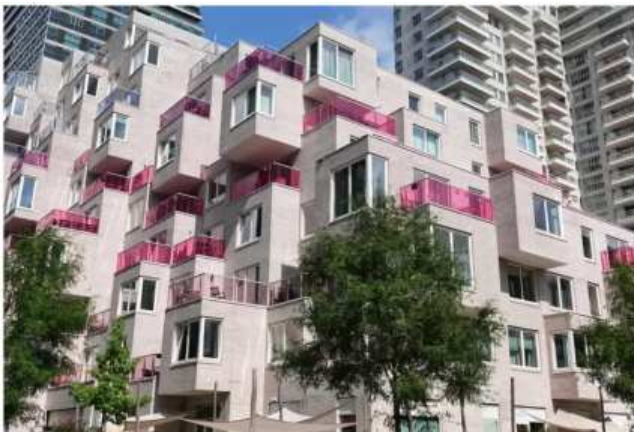
Nieuwbouw aan de Zuidas in Amsterdam. Beeld Bertinda van Dam / HH
