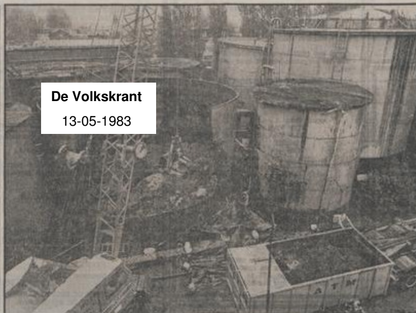
Op het voormalige EMK-terrein worden de tanks met gif leeggehaald. De hele sanering duurt tot begin volgend jaar.
