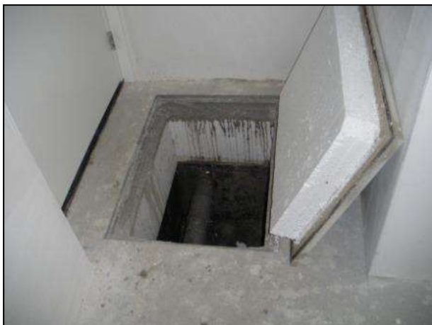
Afb. 7 Isolatie in de vloer
