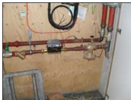
Afb. 11 a. Stadsverwarmingsunit (tevens tapwater) b. Secundaire stadsverwarmingsaansluiting (alleen CV)
