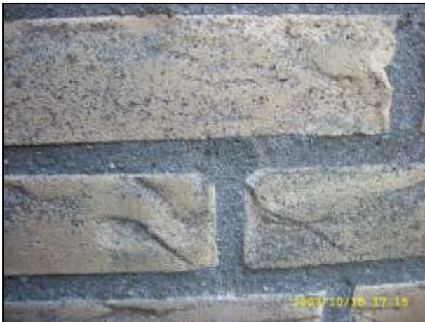
Afb. 3 Boorgat in de gevel
