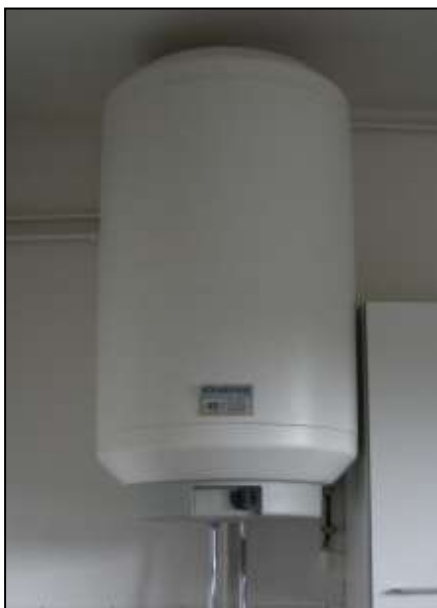
Afb. 12 Elektrische boiler (links) en geiser (rechts)
