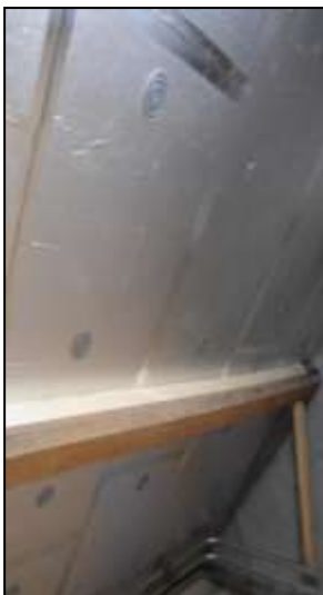
Afb. 6 Isolatie op vliering tussen de gordingen
