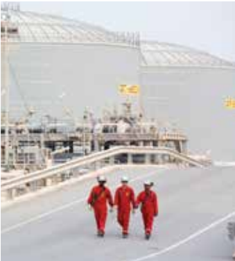
OPSLAGINSTALLATIE PEARL GTL, QATAR
