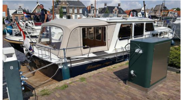
Aanlegkade voor afgifte toiletwater in gebruik door zelfs twee schepen (Lemmer). Slang moet worden opgehaald bij de brugwachter.
