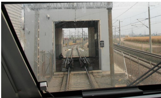
Foto Spoorwisselaar installatie bij Sevilla, Spanje
