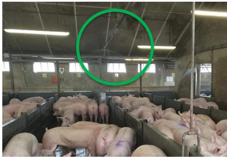
Figuur 15 Wachtruimte in slachthuis met waterverneveling
