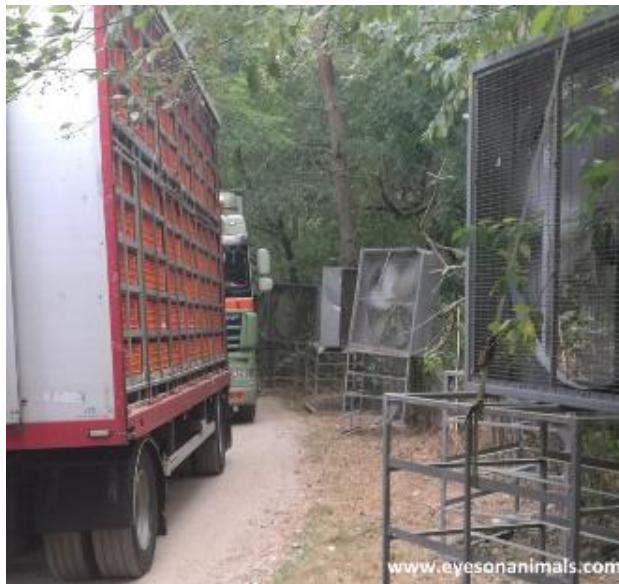
Goede ventilatoren bij pluimveeslachterij in NL
