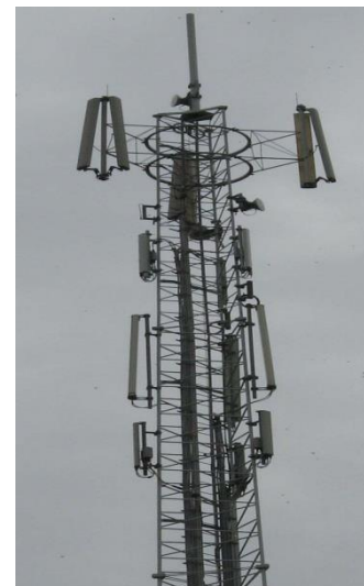
Het “digitale” asbest van Nu
