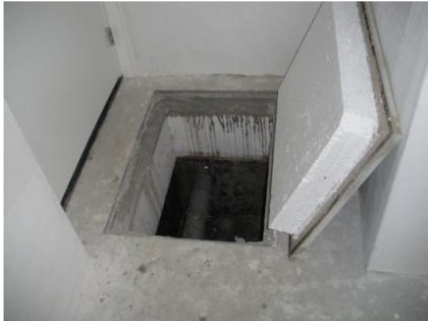
Afb. 7 Isolatie in de vloer
