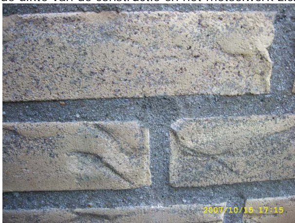
Afb. 3 Boorgat in de gevel
