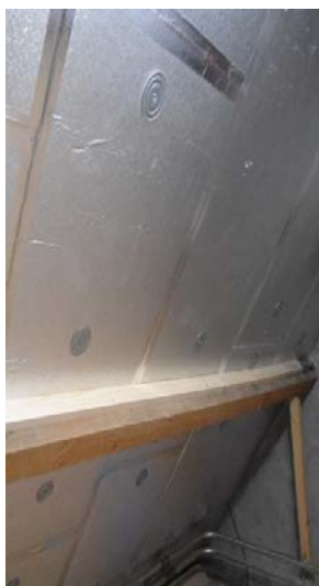
Afb. 6 Isolatie op vliering tussen de gordingen
