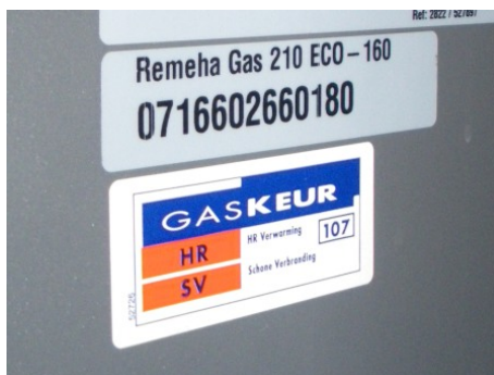
Afb. 9 CV-ketel met HR keur (HR107)
