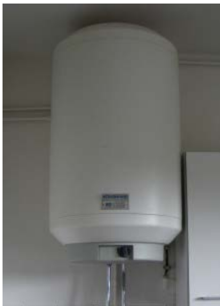
Afb. 12 Elektrische boiler (links) en geiser (rechts)
