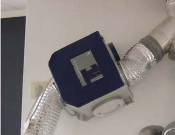
Afb. 13 Ventilatieunit voor enkel mechanische afzuiging
