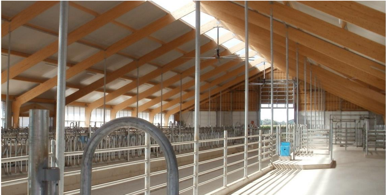
Afb. 2 Voorbeeld rundveestal (ligboxenstal).
