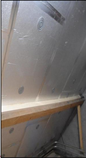
Afb. 6 Isolatie op vliering tussen de gordingen
