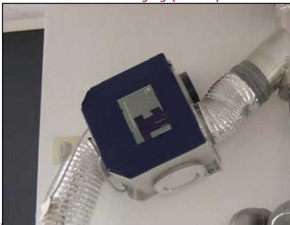
Afb. 13 Ventilatieunit voor enkel mechanische afzuiging
