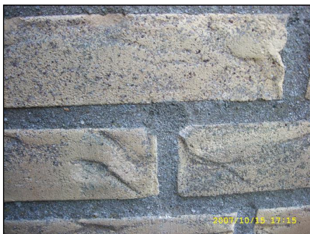
Afb. 3 Boorgat in de gevel
