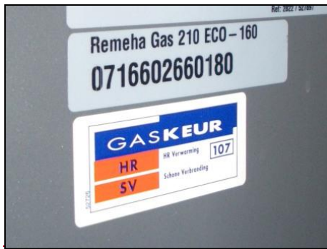
Afb. 9 CV-ketel met HR-keur (HR107)
