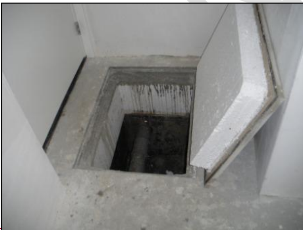
Afb. 7 Isolatie in de vloer
