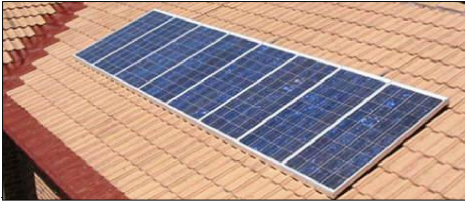
Afb. 16 PV panelen met afmeting van ongeveer 1,55 x 0,80 m (4,5 pan hoog, 4 pannen breed) Facturen, documenten en rapporten
