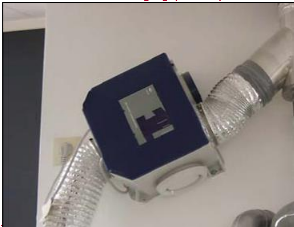
Afb. 13 Ventilatieunit voor enkel mechanische afzuiging
