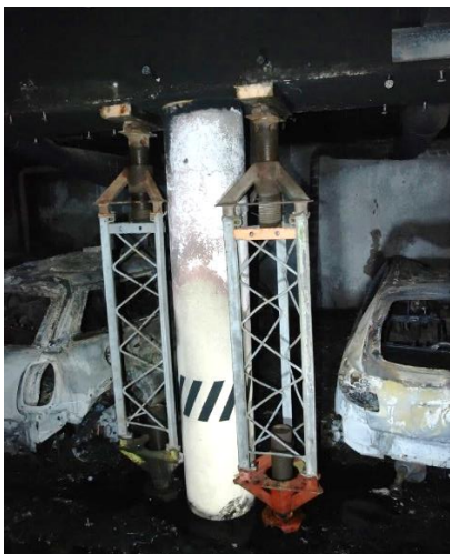
Foto 19: Versterking van de kolommen.
