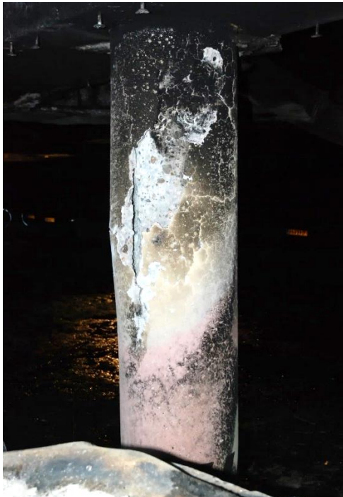
Foto 12: Gescheurde betonnen kolom.
