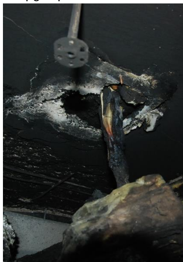
Foto 7: Invoerszijde schacht in kelder naar woningen.
