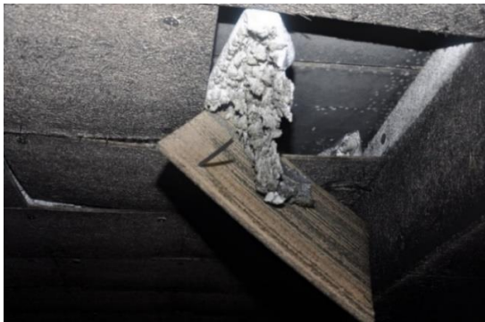
Foto 3: Aanzicht houtwolcementplaat met gesmolten EPS, refereert naar het licht geel in figuur 7.
