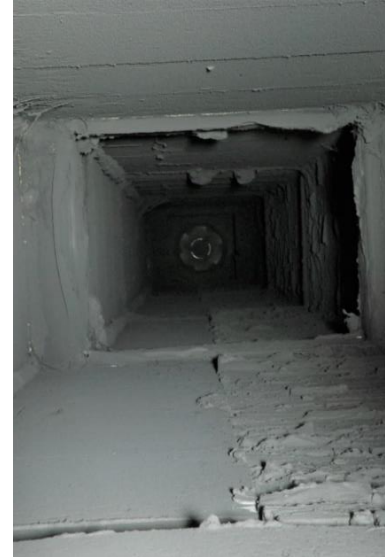
Foto 13: Binnenzijde ventilatiekanaal, vanuit kelder naar dak genomen.
