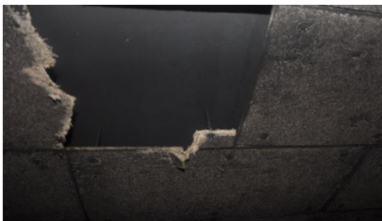
Foto 4: Houtwolcementplaten waarboven geen EPS meer aanwezig is. Refereert naar het donker geel in figuur 7
