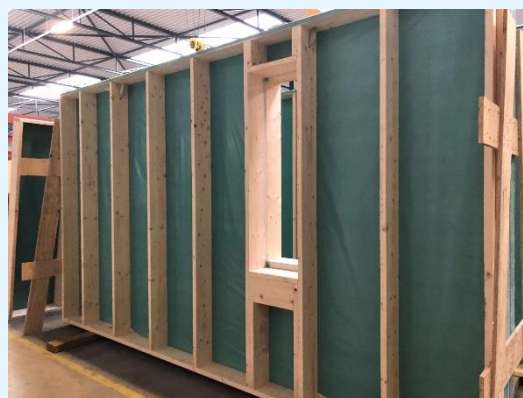
figuur 5: HSB-gevelelement voorzien van dampremmende folie
