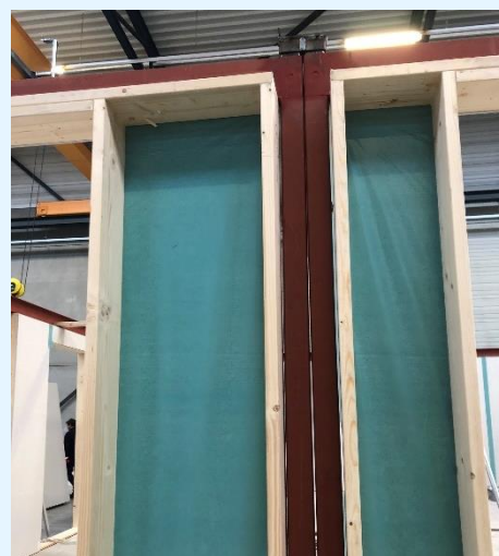
figuur 7: nog separaat af te werken koppeling tussen HSB-gevelelement en stalen frame
