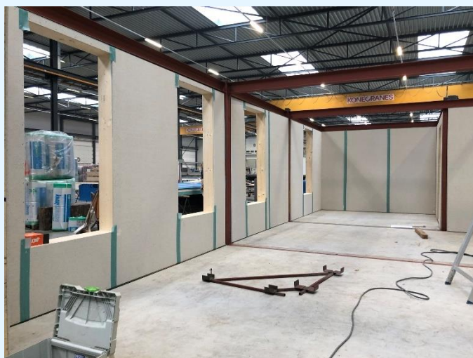
figuur 6: unitbouw: HSB-gevelelementen in stalen frames
