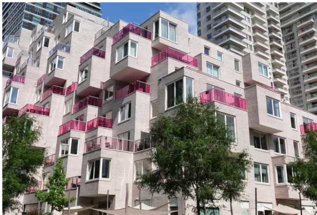
Nieuwbouw aan de Zuidas in Amsterdam. Beeld Berlinda van Dam / HH
