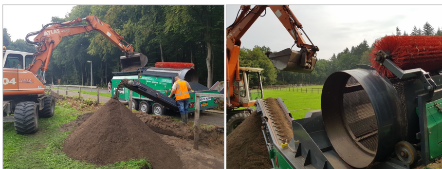
Foto's 02 en 03: Het ontgraven en zeven van een locatie met Duizendknoopbegroeiing (Foto's A. Rijnveld)
