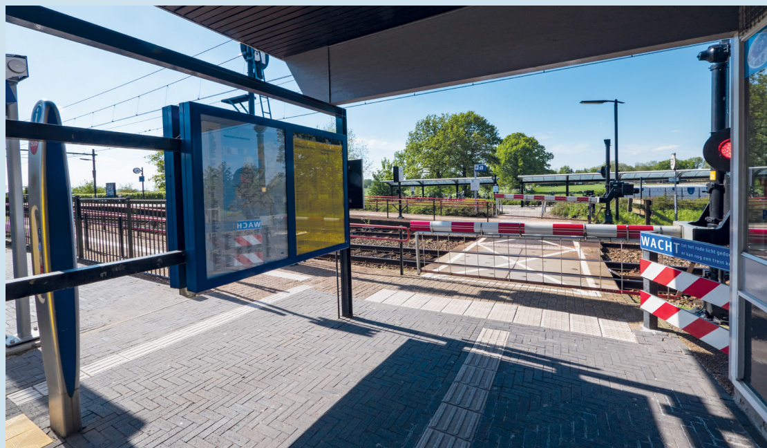
Figuur 23: Ongevalselocatie stationoverpad Ravenstein, kijkend in de looprichting van de reiziger. (Foto: Onderzoeksraad voor Veiligheid)
