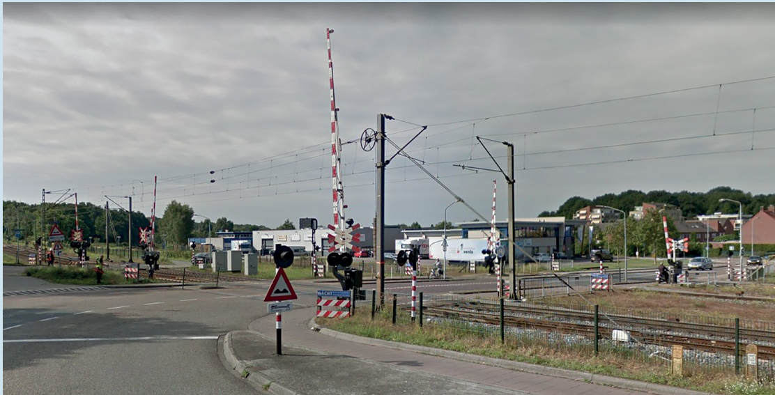
Figuur 17: De overweg in de weg Vierpaardjes in Venlo wordt vervangen door een tunnel. (Foto: Google maps)
