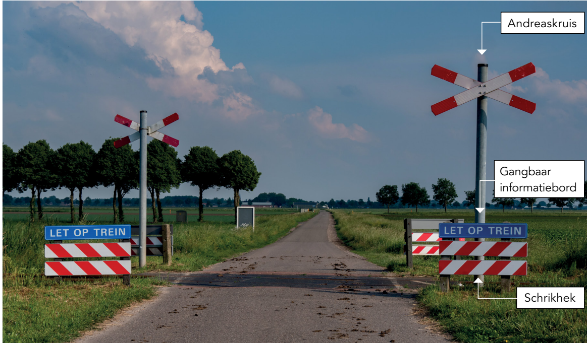
Figuur 15: Minimaal vereiste uitrusting voor een Nederlandse openbare overweg. (Foto: Onderzoeksraad voor Veiligheid)
