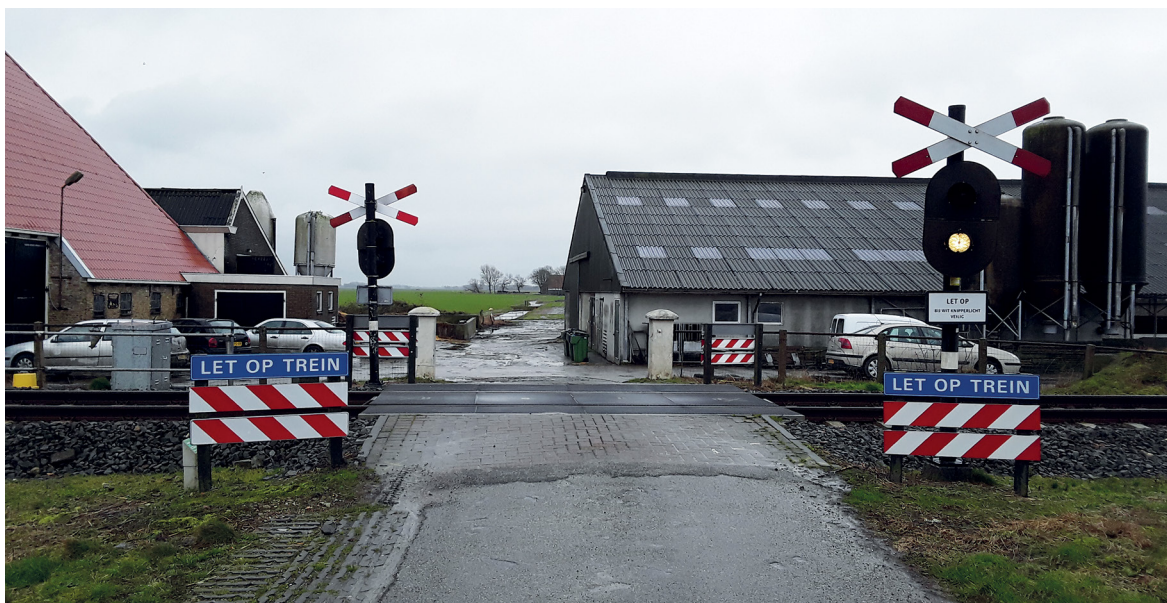
Figuur 25: Voormalige overweg in de Oude Trekweg te Harlingen, waar op 8 februari en 27 maart 2017 botsingen plaatsvonden. (Foto: Movares)
